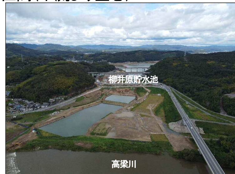
②掘削区間(下流より望む)
