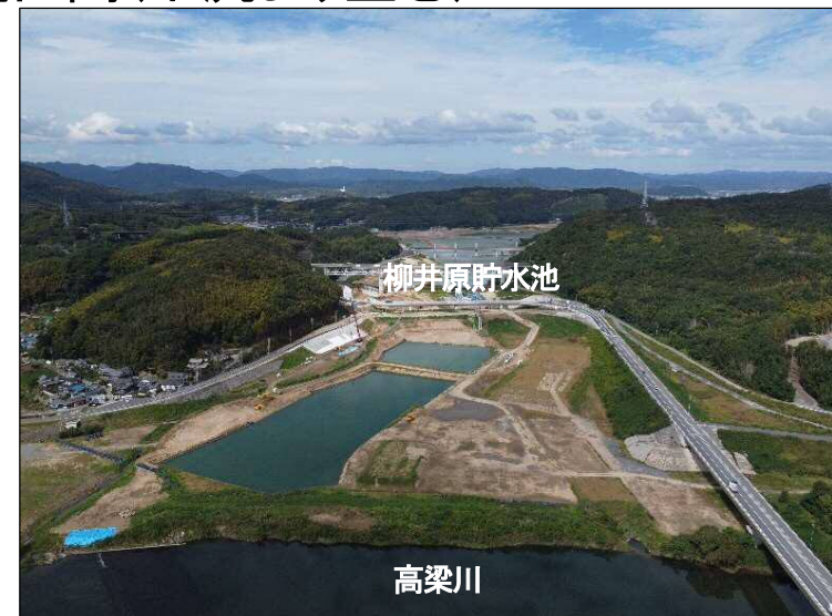
②掘削区間(下流より望む)
