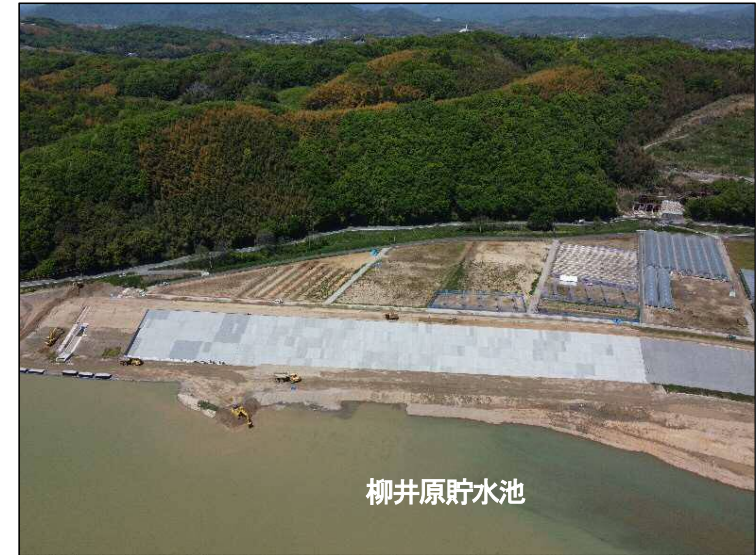
①築堤区間(貯水池より望む)
