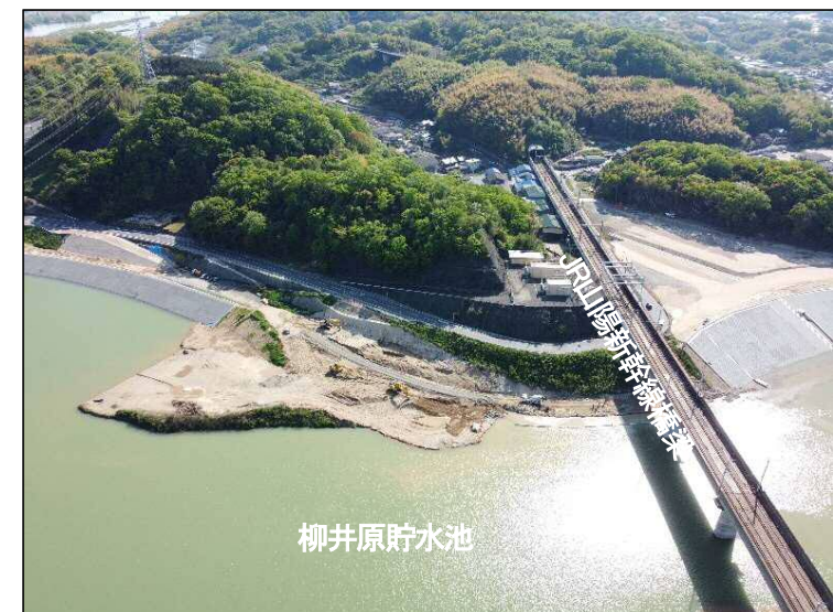
③築堤区間(貯水池より望む)
