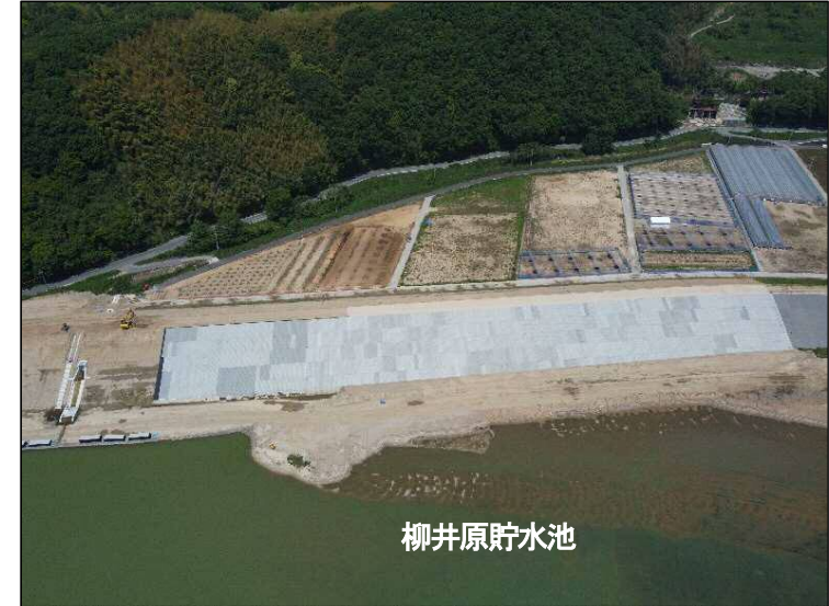
①築堤区間(貯水池より望む)
