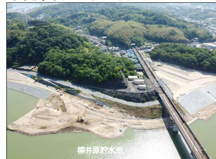
③築堤区間(貯水池より望む)
