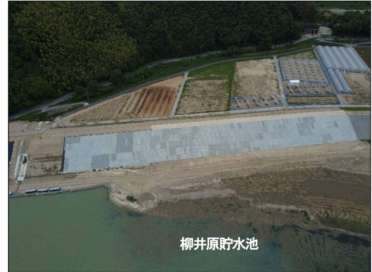
①築堤区間(貯水池より望む)
