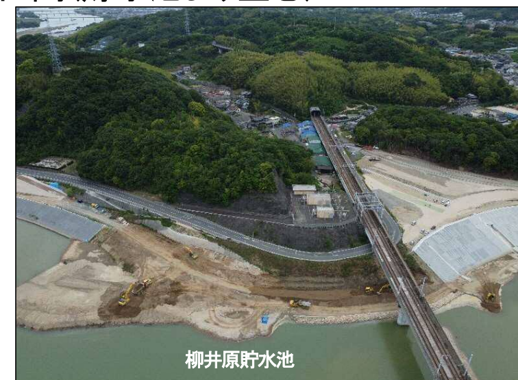
③築堤区間(貯水池より望む)
