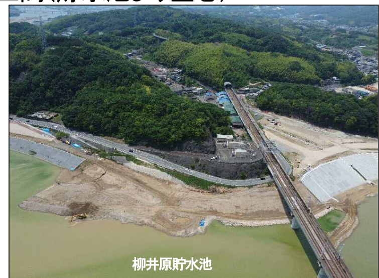
③築堤区間(貯水池より望む)
