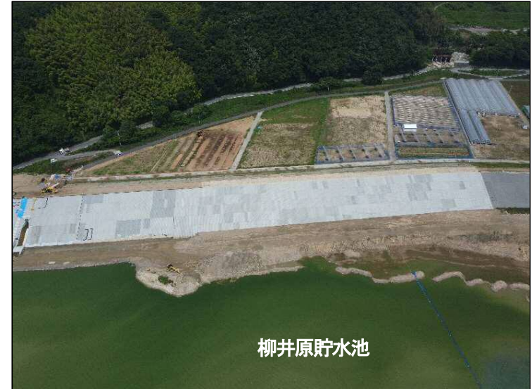
①築堤区間(貯水池より望む)
