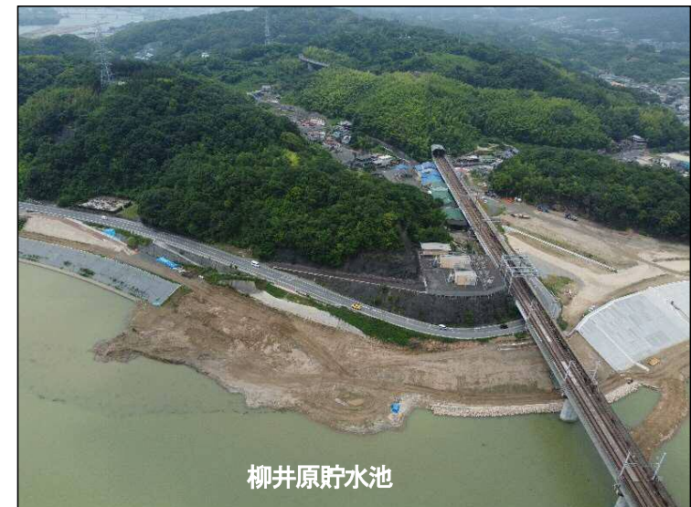
③築堤区間(貯水池より望む)
