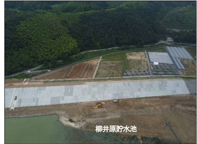
①築堤区間(貯水池より望む)
