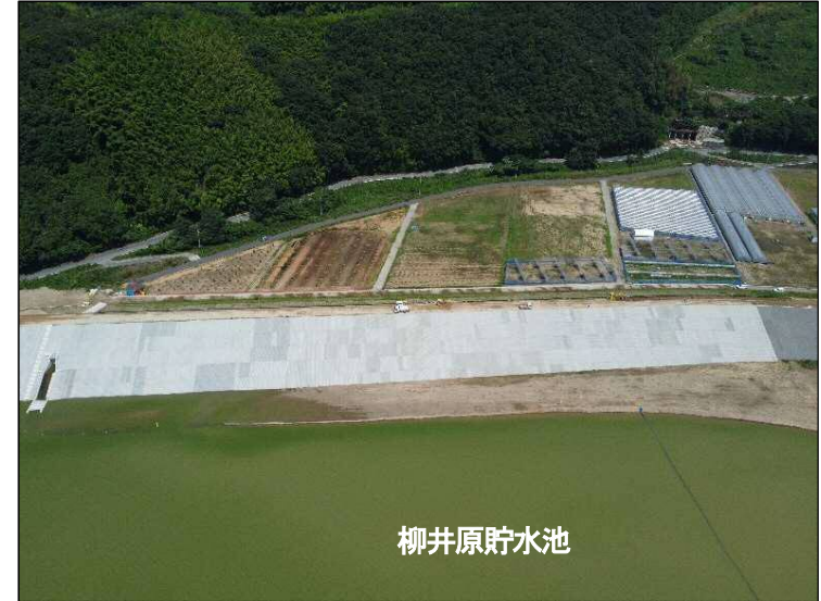
①築堤区間(貯水池より望む)
