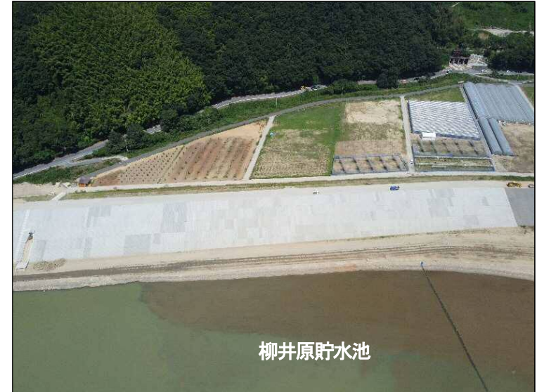
①築堤区間(貯水池より望む)
