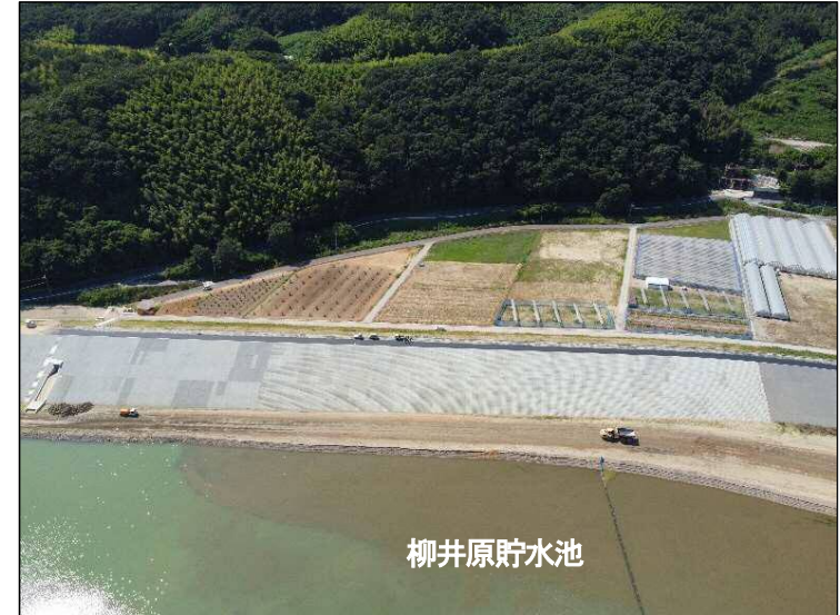
①築堤区間(貯水池より望む)
