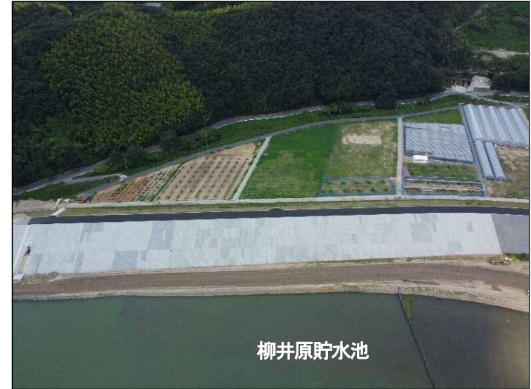
①築堤区間(貯水池より望む)
