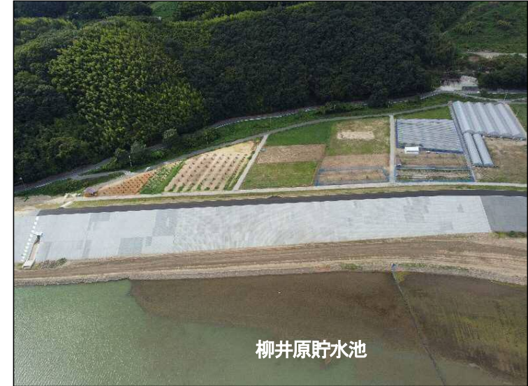
①築堤区間(貯水池より望む)
