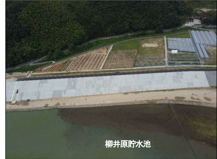
①築堤区間(貯水池より望む)
