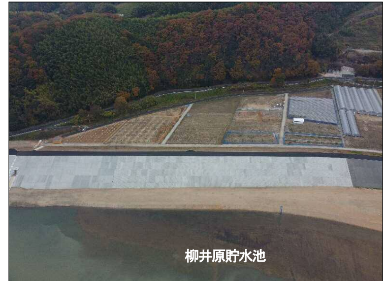
①築堤区間(貯水池より望む)
