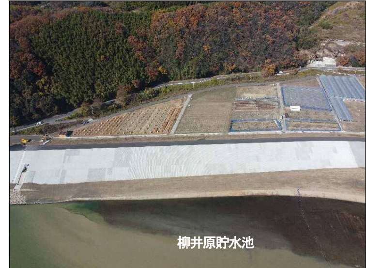
①築堤区間(貯水池より望む)
