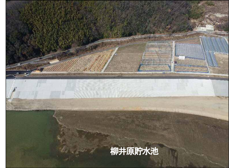
①築堤区間(貯水池より望む)
