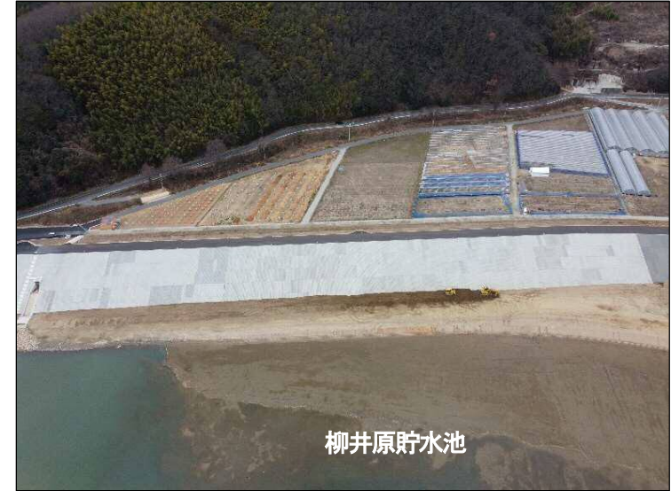
①築堤区間(貯水池より望む)
