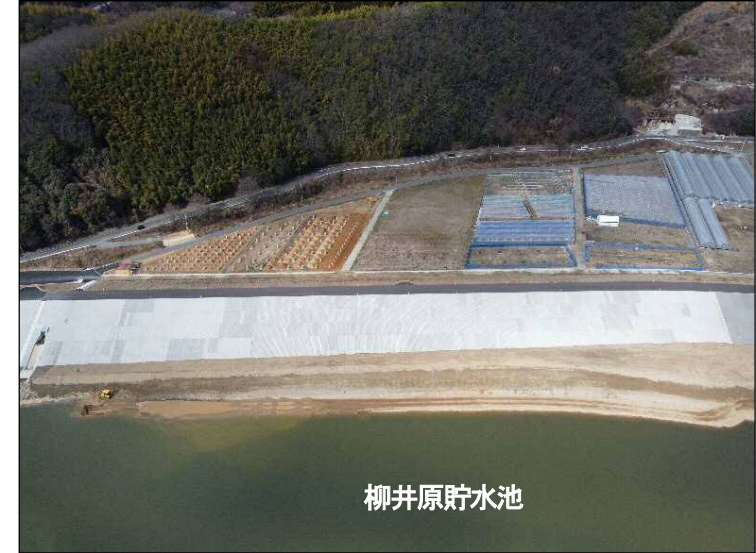
①築堤区間(貯水池より望む)
