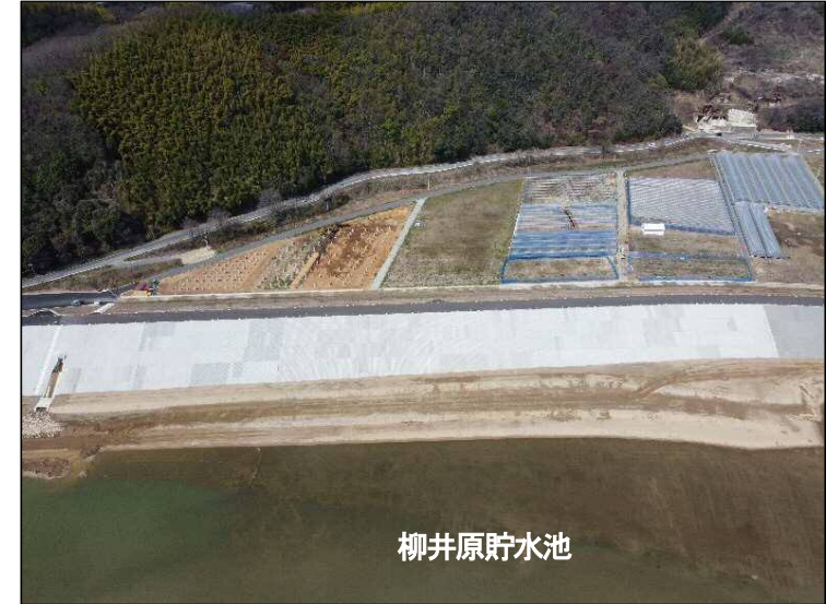
①築堤区間(貯水池より望む)
