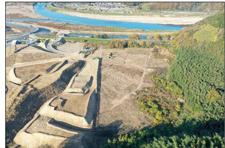
②貯水池から見た掘削状況
