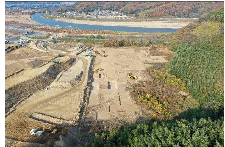
②貯水池から見た掘削状況
