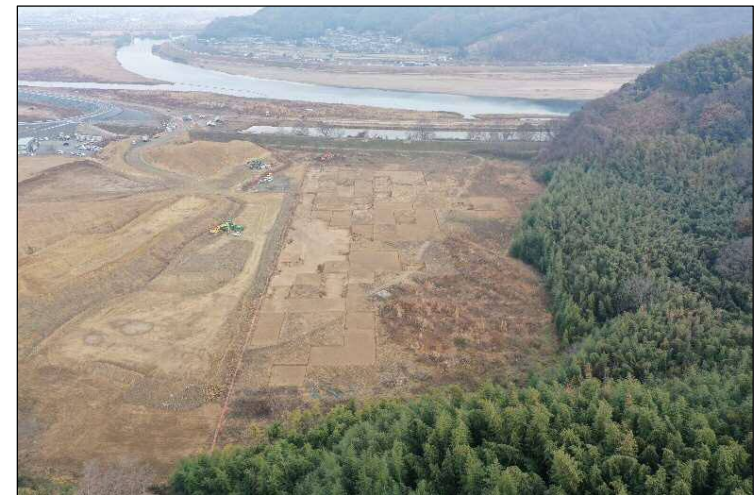
②貯水池から見た掘削状況
