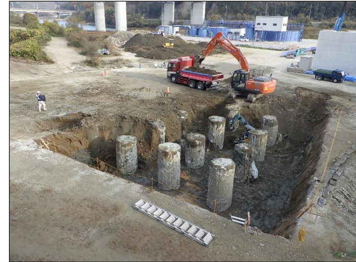
現地作業状況
