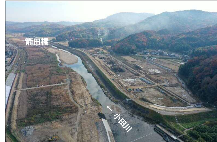
②堤防強化区間(上流より望む)
