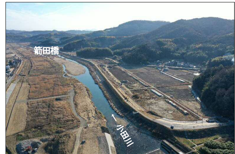
②堤防強化区間(上流より望む)
