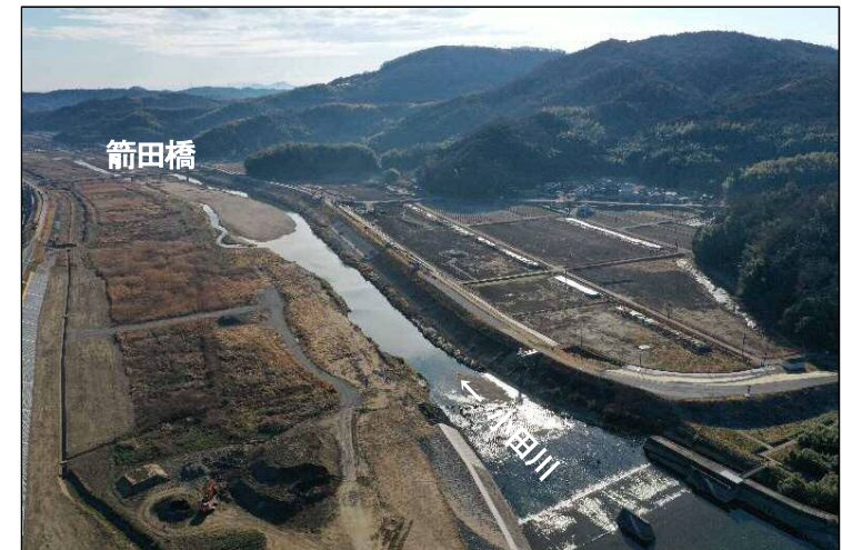
②堤防強化区間(上流より望む)
