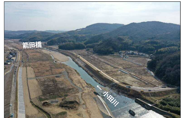
②堤防強化区間(上流より望む)
