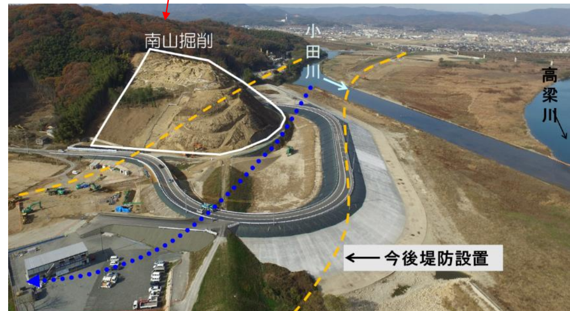
河道拡幅(南山掘削)状況
