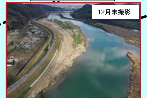
河道掘削(高梁川)
