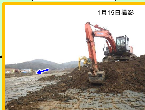
河道掘削(小田川)
