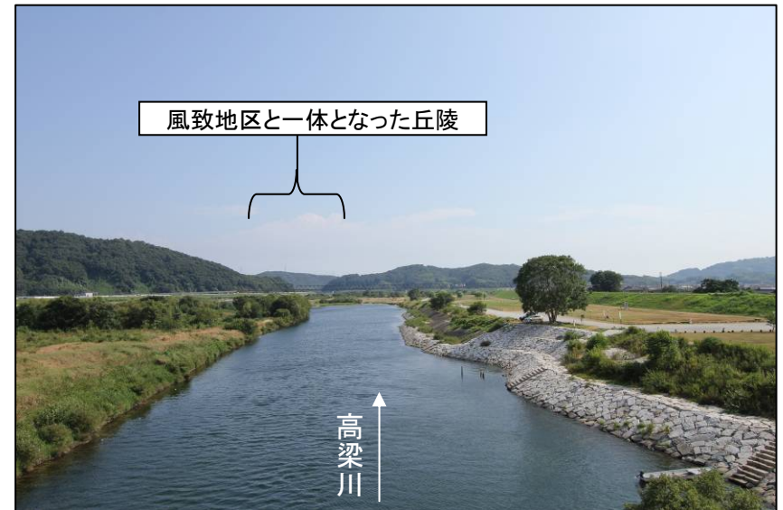
川辺歩道橋からの眺望景観(現況)
