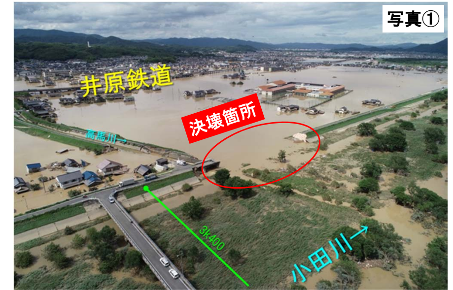
小田川左岸3k400付近堤内地
