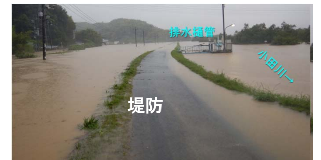
堤防からの越水の発生状況
