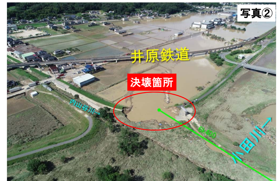
小田川左岸6k400付近堤内地
