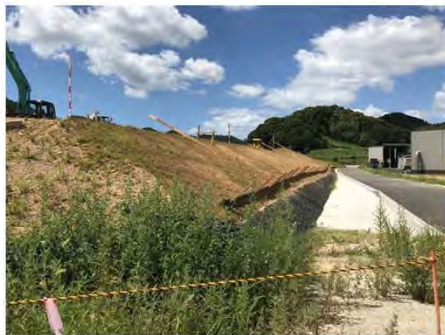
法面の緑化（吹付施工）
