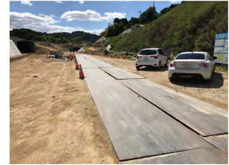
散水の代わりに敷鉄板を設置
