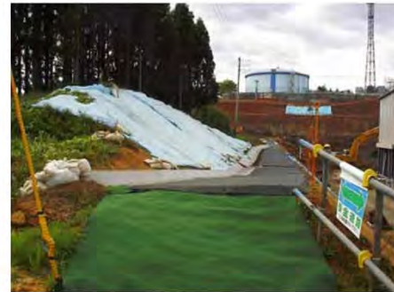
散水の代わりに法面へシートを被覆
