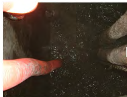
原水槽（曝気中）
