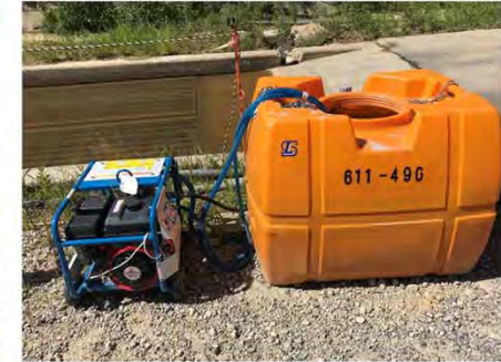
高圧洗浄機の設置
