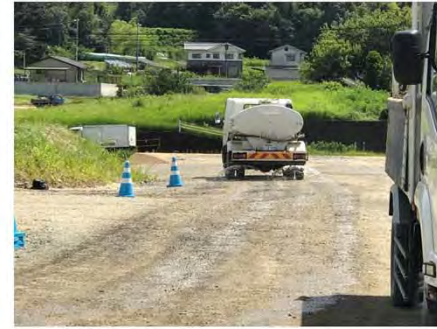
散水車による工事用道路の散水
