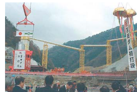
初打設(平成12年12月17日)
