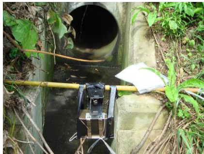
アンダーパスの調査状況 (自動撮影装置)
