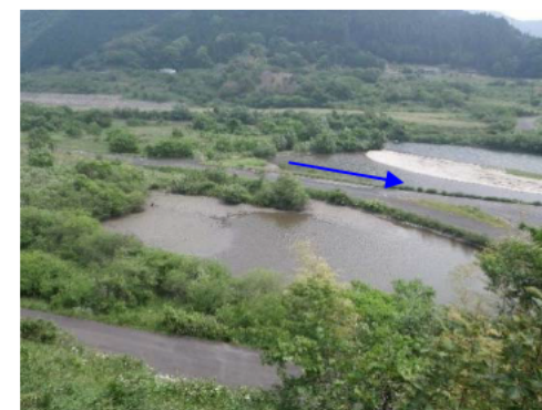
右岸下流側より 湿地環境整備箇所周辺を望む
