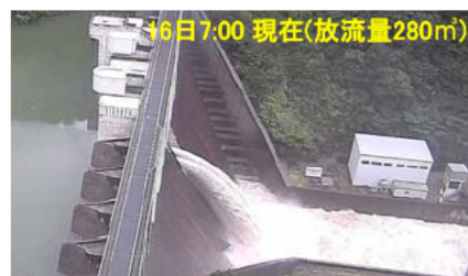
苦田ダム放流時の状況
