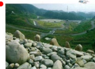
鞍部ダム堤頂より望む
