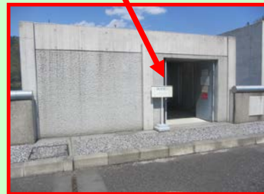
堤体見学室入口
