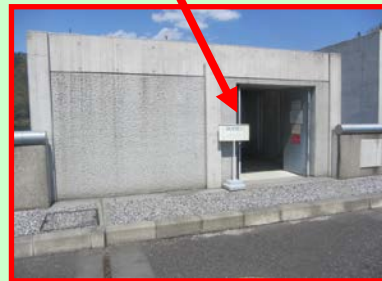
堤体見学室入口
