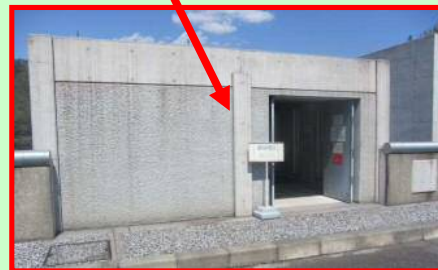
堤体入口(見学不可)
