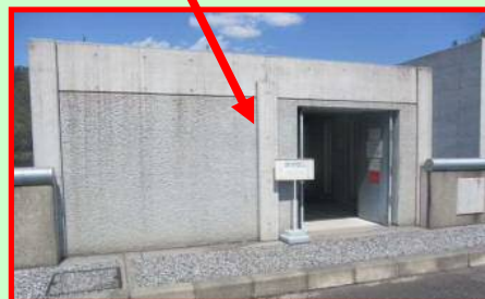
堤体入口(見学不可)
