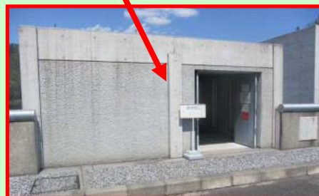
堤体入口(見学不可)
