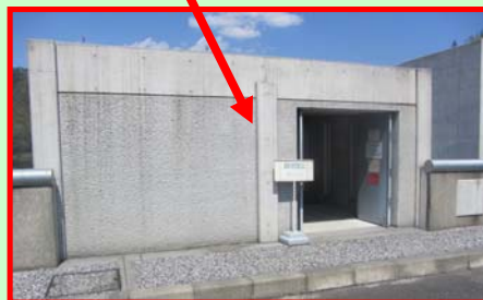
堤体入口(見学不可)
