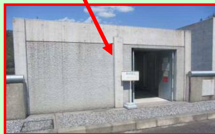
堤体入口(見学不可)
