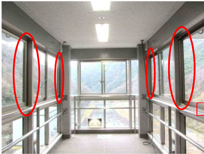
水位維持ゲート見学室
