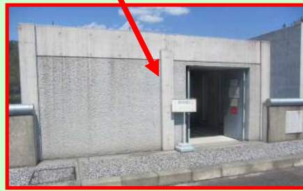
堤体入口(見学不可)
