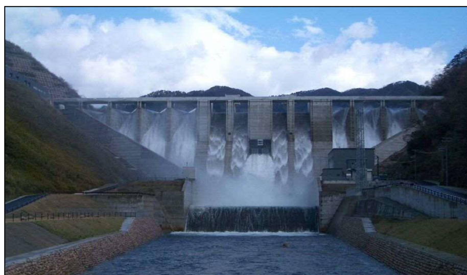
試験湛水 平成16年12月4日撮影
