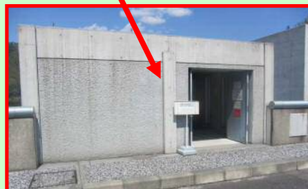
堤体入口(見学不可)
