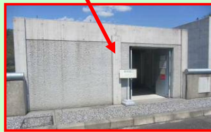
堤体内見学室
