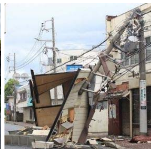
<飛来物による電柱倒壊の事例>
