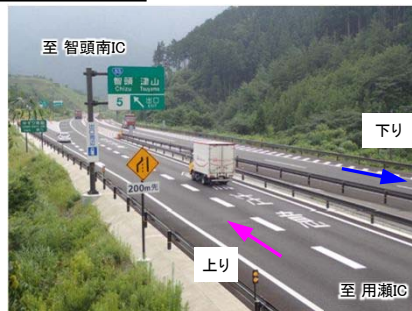
写真① 智頭IC上り線 (R2.6 完成)
