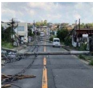
<電柱の倒壊による道路閉塞の事例>
