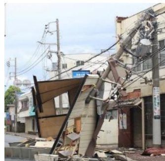
＜飛来物による電柱倒壊の事例＞
