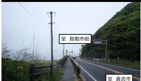
写真②：歩道状況②
