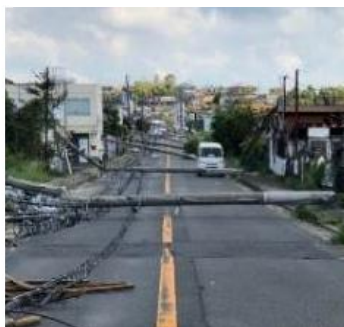
＜電柱の倒壊による道路閉塞の事例＞
