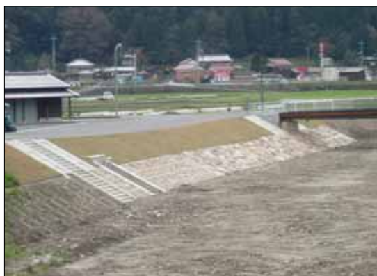
【千代川用瀬堤防工事】
