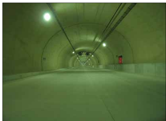
【志戸坂峠道路智頭トンネル外照明設備工事】
