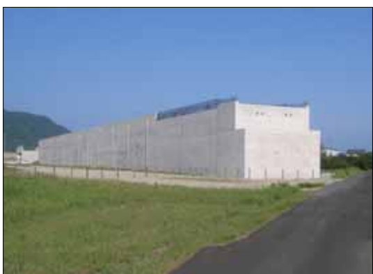
【駟馳山バイパス蒲生川橋下部工事】
