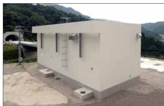
【志戸坂峠道路上市場電気室新築工事】
