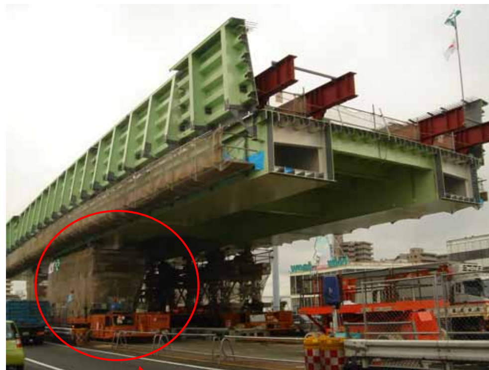
【他工事事例】 国道2号岡山バイパス(岡山市内立体事業)におけるドーリー(自走多軸台車)での架設状況写真
