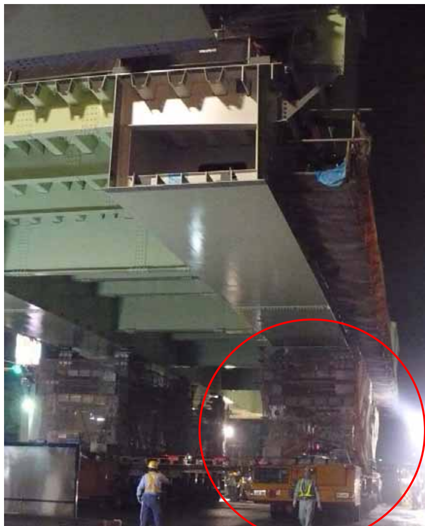
【他工事事例】 国道2号岡山バイパス(岡山市内立体事業)におけるドーリー(自走多軸台車)での架設状況写真
