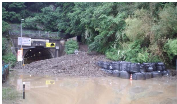
土砂流出状況(H29.6.1)
